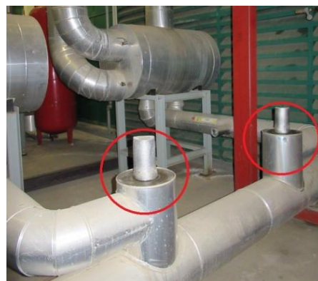
Detalle de dos válvulas de amoníaco líquido a la entrada de los evaporadores Foto. C.Artero
