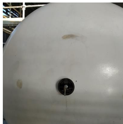
Indicador de nivel mediante galga rotativa en recipiente a presión. Foto: M.Albaladejo
