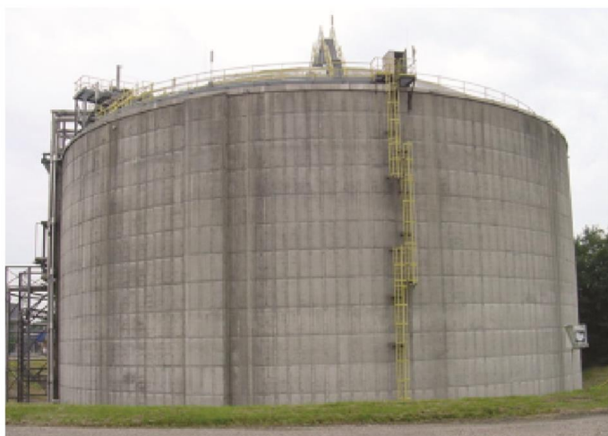
Tanque atmosférico refrigerado, de pared interior de acero, rodeado por muro de hormigón.
