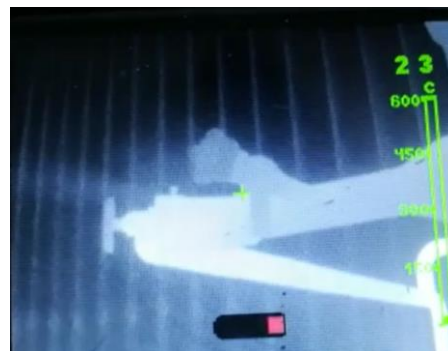
Localización de fuga de amoníaco con cámara térmica. Foto: J.M.Soriano (bombero Leganés)
