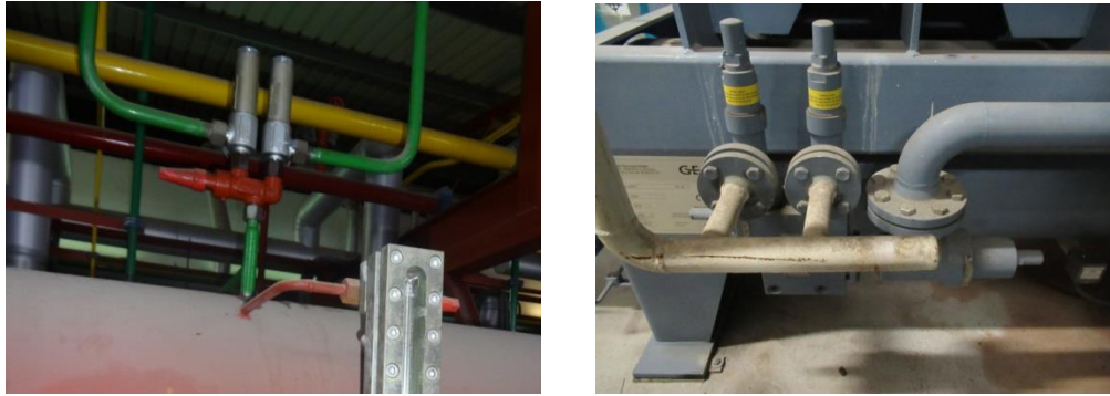
Válvula de tres vías sobre recipiente principal de amoníaco a la izquierda y en un compresor a la derecha Foto. C.Artero
