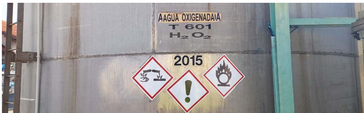
Imagen 15. Señalización en depósitos de almacenamiento de H_2O_2 .
