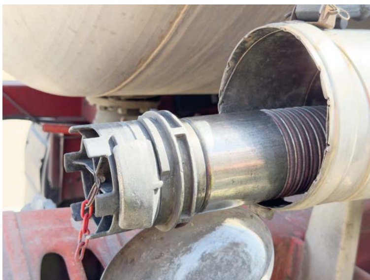
Imagen 38. Mangote para descarga de cisterna de H_2O_2 .
