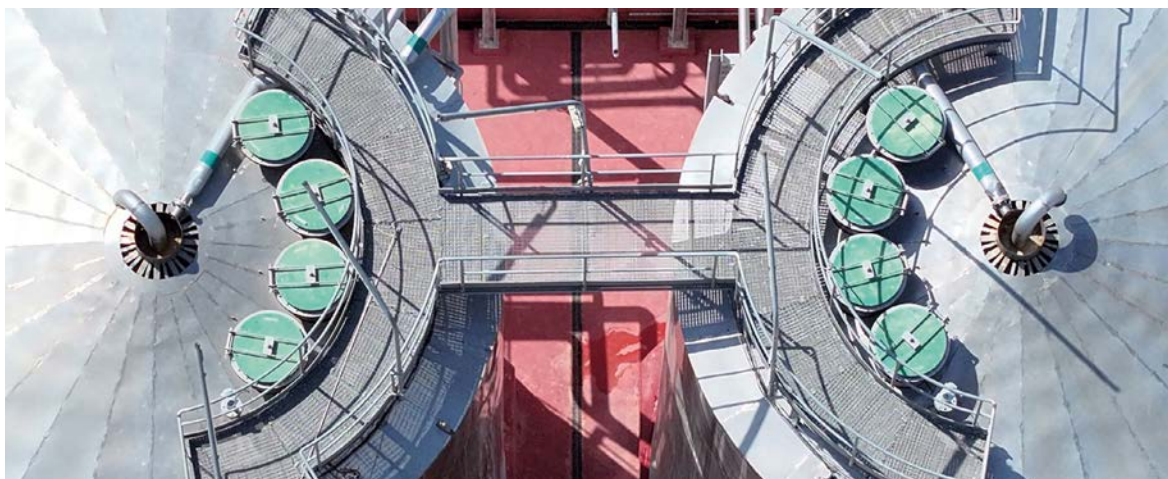
Imagen 18. Tapas para liberar presión en depósitos verticales.
