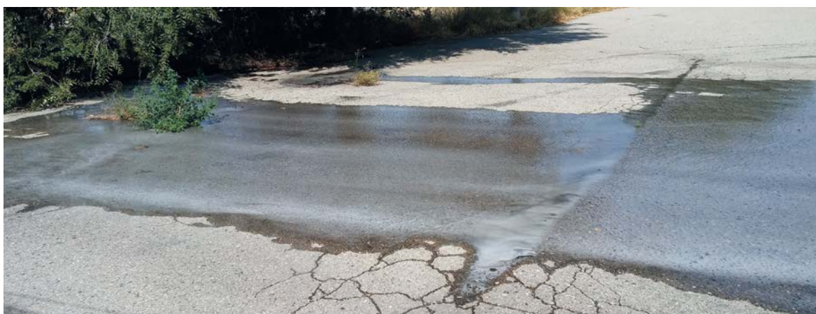
Imagen 8. Efectos de un derrame de H 2 O 2 diluido con agua.
