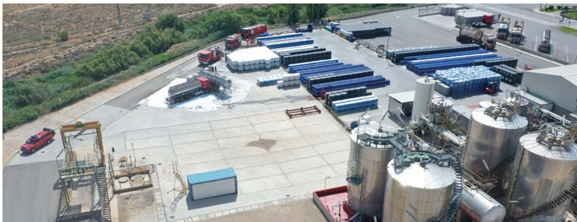
Imagen 46. Simulacro de accidente con cisternas de peróxido de hidrógeno.
